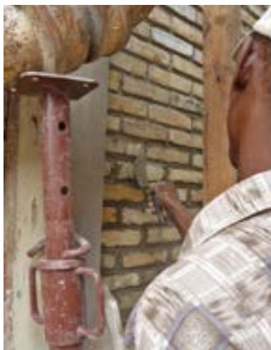
PHOTO 135 Des réparations bien intentionnées mais inadéquates avec mortier en ciment dans un appareil en briques (en haut et à droite) et un hourdage de ciment pour un colombage (en bas). Torchis de chaux et plâtre de chaux devraient être utilisés.
