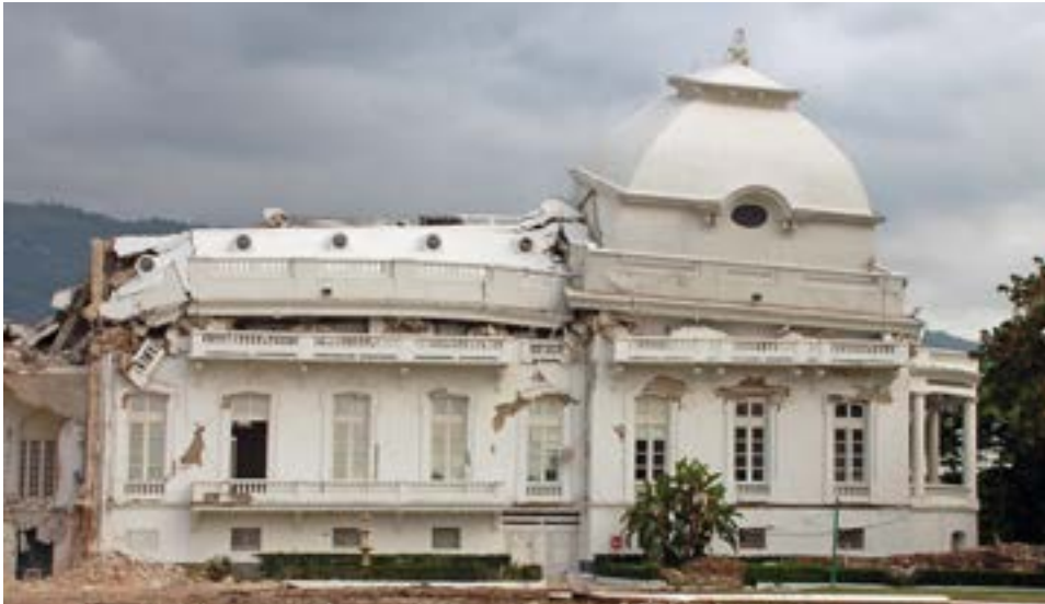
PHOTO 28 Le Palais National, construit en 1918, donne un exemple de l'utilisation précoce du béton armé en Haïti. Ces constructions se sont tout ou partie effondrées.
