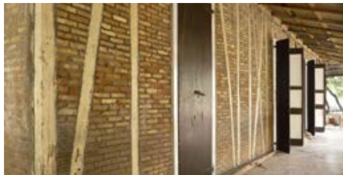
PHOTO 38 Colombage avec hourdage de briques et de torchis de chaux au 30 de l'avenue Lamartinière.
