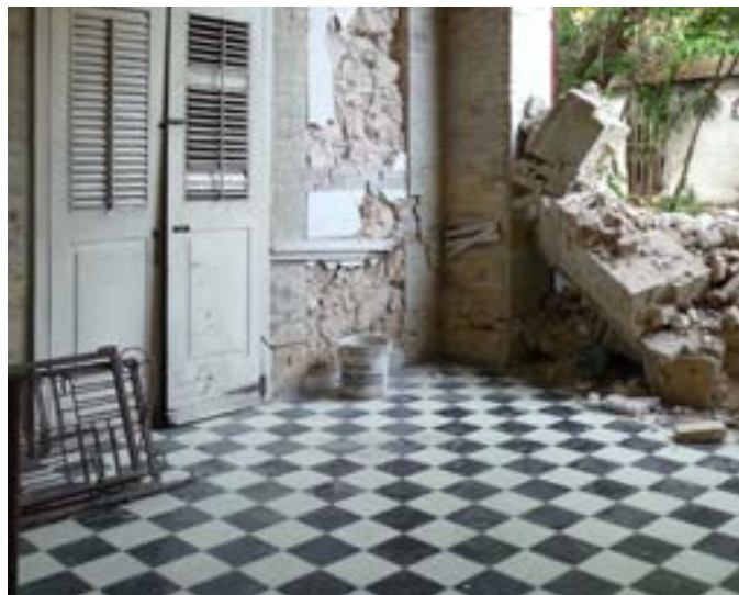
PHOTO 60 Un revêtement de carreaux sur une dalle de terre-plein au 5 de la première Impasse Lavaud.
