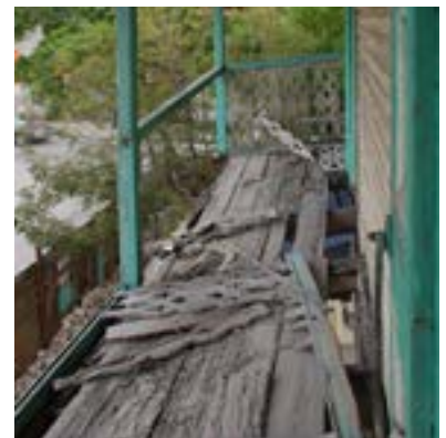
PHOTO 78 Balcon du premier étage rendu dangereux par les ravages causés par les termites.
