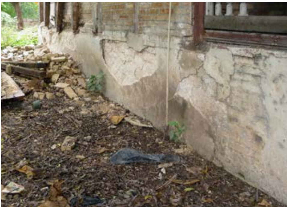
PHOTO 50 Effritement de la finition extérieure en plâtre de cette maison sise au 84 avenue Lamartinière qui révèle deux segments contigus de la souche d'un mur de fondation. L'un est en pierres calcaires irrégulières, à gauche et l'autre en briques, à droite.
