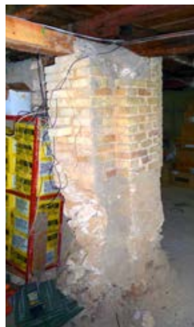
PHOTO 52 Un espace sanitaire creusé au 84 de l'avenue Lamartinière laisse voir un ancien pilier hors sol en briques et son socle non enduit fait d'un mortier constitué de pierres calcaires et de terre crue.
