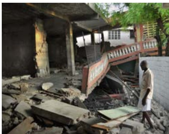
FIGURE 112 Petite maison à colombage accueillant une école au 16 de l'avenue Lamartinière et un immeuble de deux étages derrière elle. De grosses portions de cet ajout se sont effondrées complètement, mais le bâtiment original est intact et toujours en service.
