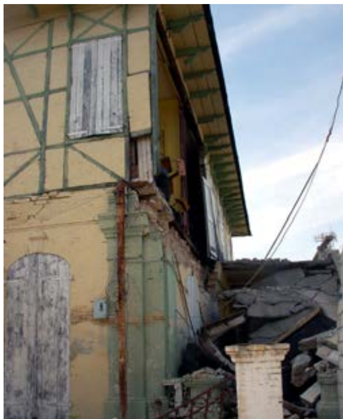
PHOTO 109 Intérieur et extérieur du 51 de l'avenue Christophe montrant l'ajout en béton armé attenant à la maison en bois et à colombage. Les deux parties se sont écarté l'une de l'autre pendant le séisme.
