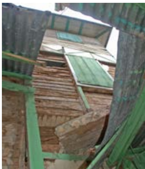
PHOTO 89 Un torchis de briques qui avait été posé à nouveau avec un mortier de ciment s'est détaché par morceaux énormes pendant le séisme, occasionnant des dégâts à la construction du dessous.
