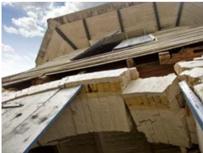
PHOTO 105 Voûte très endommagée et charpente en bois au-dessus, déplacée. Absence de tirants, combinée à la détérioration des semelles en bois, ont rendu cette bâtisse encore plus vulnérable.
