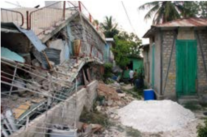
PHOTO 75 Un immeuble en béton complètement aplati, à gauche, et une maison à colombage à droite, montrant la résistance comparée de ces deux techniques de construction face au tremblement de terre.
