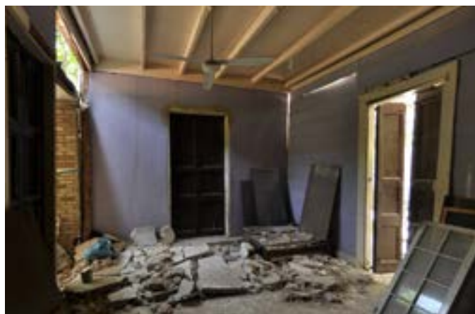
PHOTO 73 Exemples de colombages où le hourdage en remblais a été remplacé par du béton. Cette procédure a accéléré le pourrissement de la charpente en bois qui s'est alors cassée pendant le séisme provoquant l'effondrement du lourd hourdage en béton.
