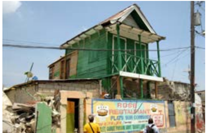
PHOTO 76 Maison gingerbread qui a survécu au milieu de plusieurs autres constructions en béton qui se sont effondrées. Les propriétaires ne veulent pas la démolir. Elle devra, cependant, être stabilisée avant de subir des réparations plus importantes.
