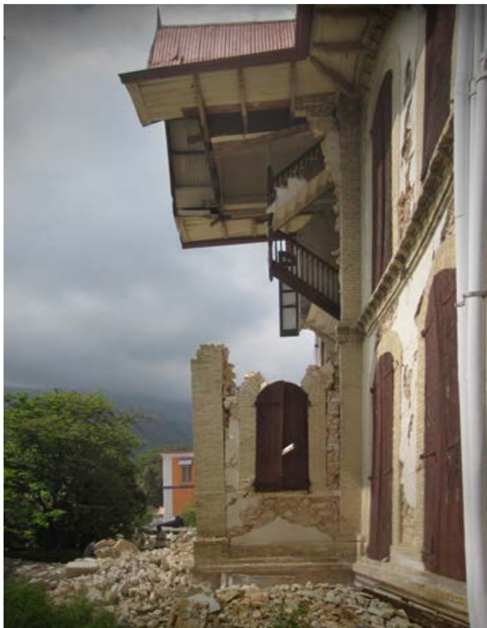
PHOTO 130 En bas, à gauche Un panneau en moellons au premier étage de la Villa Castel Fleuri qui s'est effondré montrant le déplacement de la base du pilier en briques vers la porte, résultat des forces d'expansion du panneau. En bas, à droite Le Manoir dans l'avenue John Brown montrant le degré des perturbations des murs en maçonnerie, causés par la dégradation rapide des panneaux en moellons pendant le séisme.
