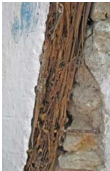
PHOTO 62 Les termites abondent à Port-au-Prince et de nombreuses constructions en bois sont sérieusement endommagées par leurs attaques.
