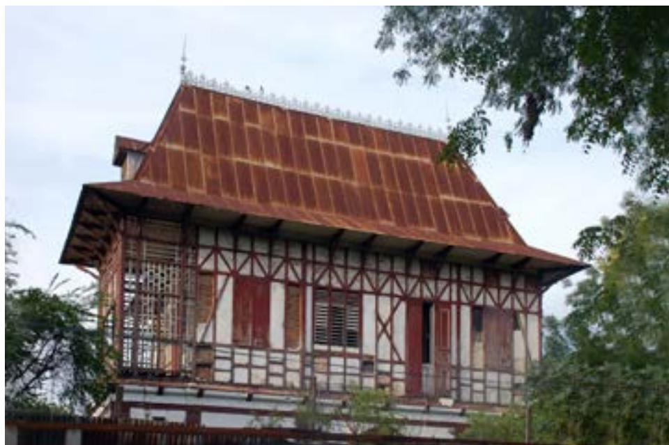
PHOTO 55 Les toits en métal ferreux sont très courants dans les maisons gingerbread . Cette maison a également une crête en métal sur la corniche.
