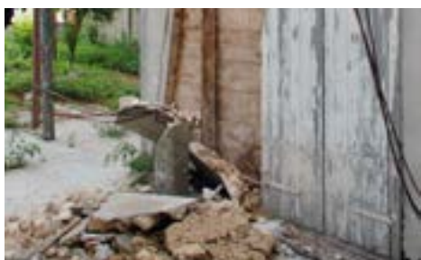
PHOTO 88 Un hourdage de moellons qui a été posé une seconde fois avec des mortiers de ciment s'est détaché par morceaux énormes des cavités dans le bois pendant le séisme occasionnant des dégâts et représentant un risque pour la sécurité.
