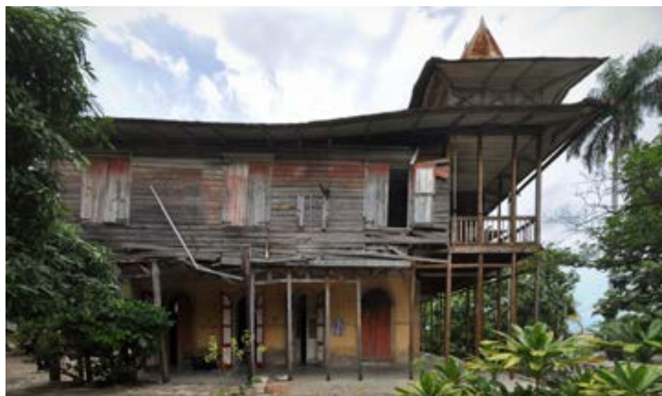
PHOTO 65: La maison de Patrice Pamphile (voir aussi les Photos 2 et 32) où l'on peut remarquer l'état de détérioration de la partie en bois de la construction qui a probablement été à un moment une galerie ouverte.
