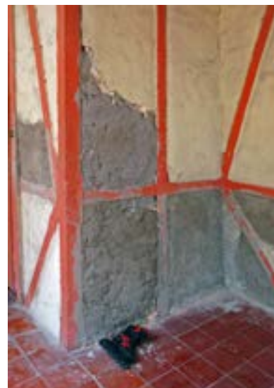
PHOTO 74 Procédure inadéquate de réparation du hourdage en moellons de ce colombage par l'utilisation de béton. Ces réparations constituent un remblayage beaucoup plus dur et mieux lié que le hourdage qu'il a remplacé.
