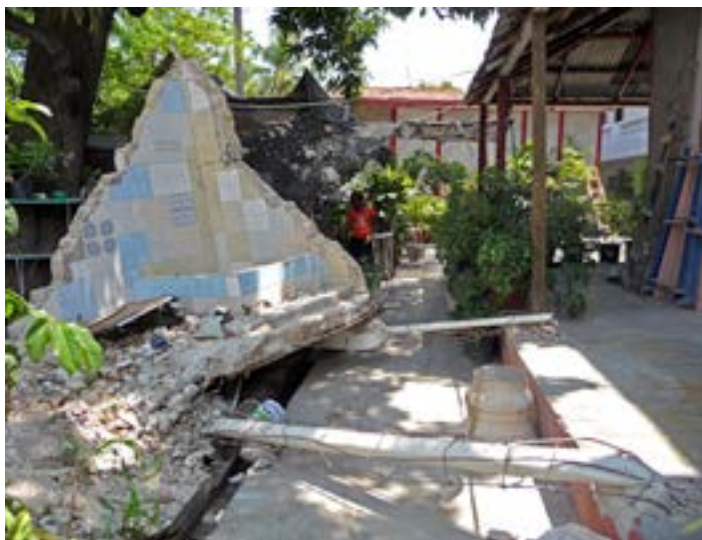
PHOTO 70 Cette salle de bains en béton ajoutée au premier étage du 5 de l'avenue Lamartinière a atterri sur le sol lorsque les colonnes en béton qui le soutenaient cédèrent alors qu'elles se détachaient de la maison gingerbread mère. A noter les tuyaux de canalisation au milieu des barres de fer des colonnes distordues.
