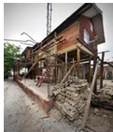
PHOTO 134 La charpente en béton armé et les ajouts en blocs de ciment de cette maison au 24 de l'avenue Lamartinière se sont écroulés dans le tremblement de terre et ont été enlevés. Le propriétaire, l'architecte Gilbert Mangonès exécute toutes les réparations avec charpente et revêtement en bois plus compatibles avec la charpente en bois flexible de la maison originale et moins susceptibles de s'effondrer lors d'un prochain séisme.
