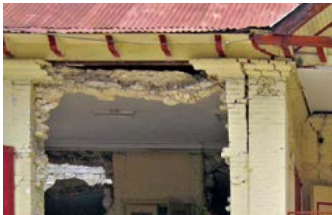
PHOTO 104 Effondrement total dans ce bâtiment en maçonnerie très endommagée fut évité grâce aux tirants en fer en haut des murs, avec des plaques de fond exposées.
