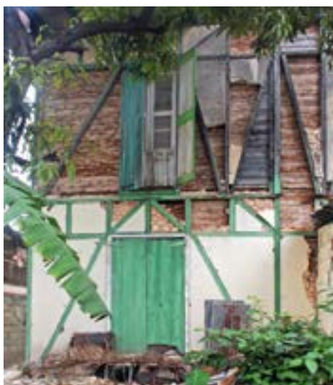
PHOTO 86 Une grande partie du moellonnage de ce colombage s'est détachée des parois du premier étage pendant le séisme.
