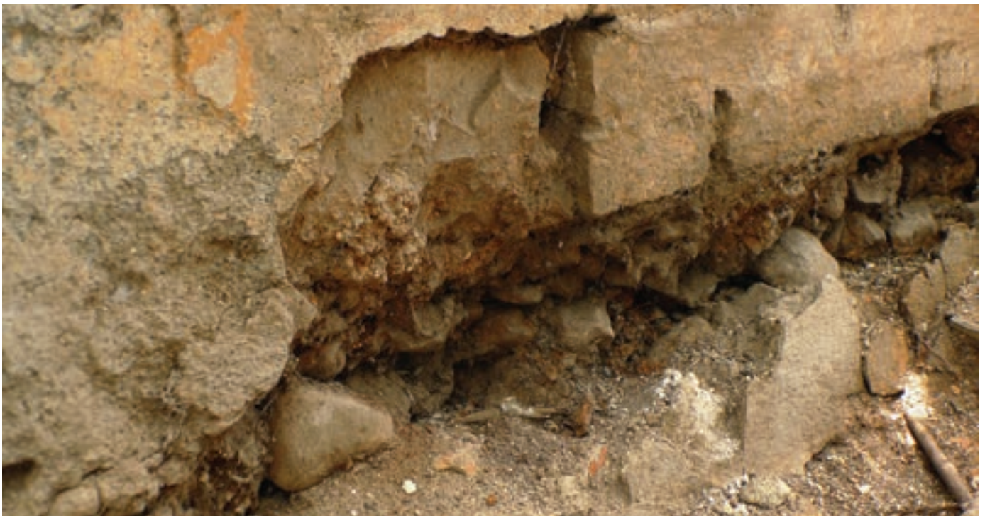
PHOTO 92 Erosion à la surface et à la base du mur.
