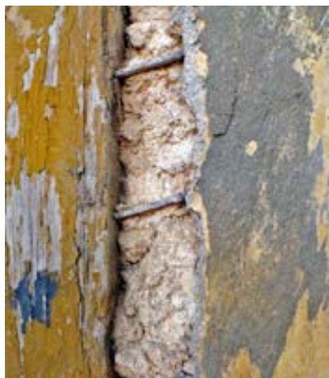
PHOTO 43 Des clous aident à contenir le hourdage en terre crue.
