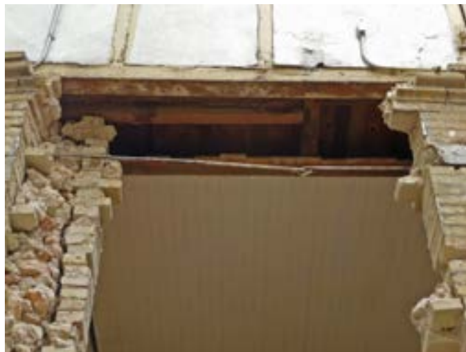
PHOTO 106 Barres de tension en fer exposées après que le panneau de hourdage en pierres calcaires se soit détaché. Les tirants ont peut-être empêché l'effondrement total du mur.
