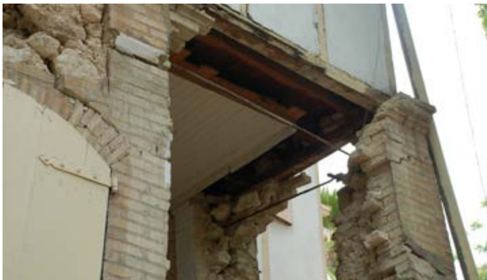
PHOTO 93 Les murs porteurs en maçonnerie du rez-de-chaussée de la Maison Dufort dans la rue du Travail Deuxième sont très endommagés et se sont partiellement effondrés, alors que le premier étage à charpente de bois n'a subi presque aucun dommage. Les attaches horizontales en fer, visibles ici et sur la Photo 95, ont permis d'éviter l'effondrement de ce pilier d'angle malgré les importants dégâts causés à la maçonnerie. Sans ces attaches, il est possible que le bâtiment se soit entièrement écroulé.
