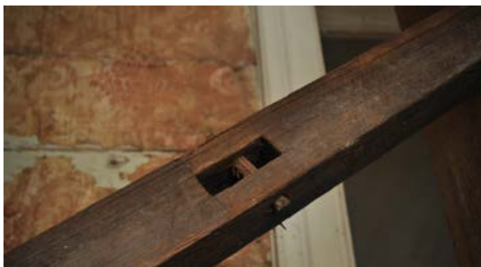
PHOTO 32 En haut Intérieur d'une pièce construite au-dessus de ce qui reste de la galerie de la maison Pamphile au 4 de la rue Casséus qui figure sur la Photo 2. L'intérieur montre les caractéristiques typiques en Haïti d'une construction en bois de charpente qui se situe quelque part entre les charpentes lourdes assemblées en tenons et mortaises comme dans les constructions en France de l'époque médiévale et de la Renaissance et les charpentes « à pans » de bois sciés plus légers des constructions américaines du dix-neuvième siècle. En bas Cet exemple de mortaise et tenon avec chevilles en bois provient de la maison Bazin, 8 rue du Travail Deuxième.
