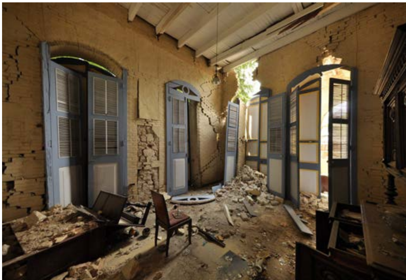
PHOTO 97 Maison de deux étages au 46 de l'avenue Christophe. Pendant le séisme, une partie du premier étage s'est écroulée, suivie par le reste de l'étage. Ces photos montrent le rez-de-chaussée, resté debout mais avec d'énormes cassures dans les murs de maçonnerie, particulièrement dans les angles. A droite La tige d'ancrage en fer qui retenait ensemble le bâtiment au niveau du plancher est visible là où elle a cédé en raison de la corrosion. Cette photo montre aussi comment la paroi intérieure du briquetage n'était pas liaisonnée avec les couches extérieures des moellons. Une couche de briques forme l'angle intérieur de la pièce, alors qu'au milieu de la pièce, le panneau en moellons pénètre dans toute l'épaisseur du mur.
