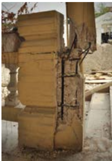
PHOTO 114 La maison Bazin dans la rue du Travail Deuxième. Une salle de bains en béton armé et blocs de ciment revêtue de bois au premier étage et visible au milieu de la photo de gauche a presque provoqué l'effondrement de toute la maison, parce qu'elle reposait sur de minces poteaux en béton fortement détérioré avec des barres d'armature rouillées. Elle était lourde, faisant osciller toute la maison, arrachant presque l'aile où se trouve la salle de bains, et a ensuite probablement entraîné dans sa chute une partie de la maison.
