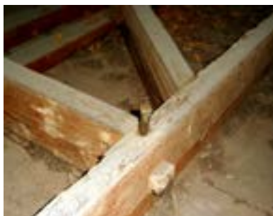
PHOTO 53 Charpente des combles en bois assemblée en mortaise et tenon retenus par de chevilles en bois.
