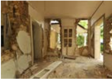
PHOTO 94 Intérieur du rez-de-chaussée de la maison d'Albert Dufort à la deuxième rue du Travail montrant un bouleversement total des panneaux en moellons. La paroi intérieure à gauche sur la photo, qui n'était pas renforcée avec des piliers en briques parce que n'ayant pas d'ouvertures pour fenêtres ni portes, s'est complètement effondrée.
