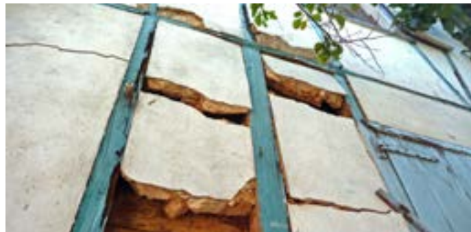
PHOTO 39 Colombage au 5 de la rue José Martí avec hourdage de pierres calcaires et torchis de terre et un enduit composé de plâtre et de chaux. On remarque le revêtement intérieur en planches.
