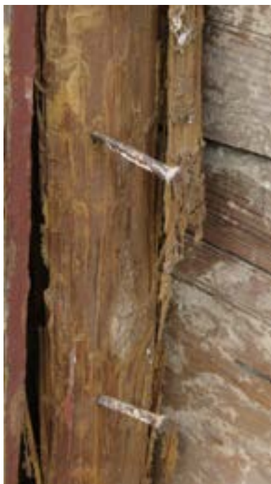
PHOTO 84 Malgré l'infestation massive de termites, ce poteau est dur et solide, retenant encore fermement des clous.
