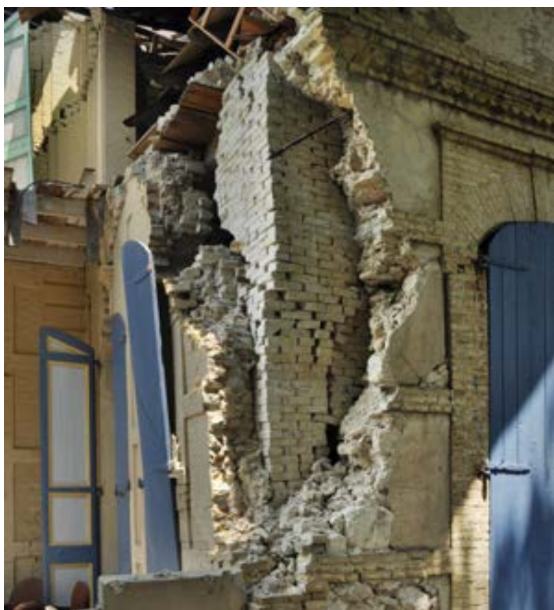
PHOTO 97 Maison de deux étages au 46 de l'avenue Christophe. Pendant le séisme, une partie du premier étage s'est écroulée, suivie par le reste de l'étage. Ces photos montrent le rez-de-chaussée, resté debout mais avec d'énormes cassures dans les murs de maçonnerie, particulièrement dans les angles. A droite La tige d'ancrage en fer qui retenait ensemble le bâtiment au niveau du plancher est visible là où elle a cédé en raison de la corrosion. Cette photo montre aussi comment la paroi intérieure du briquetage n'était pas liaisonnée avec les couches extérieures des moellons. Une couche de briques forme l'angle intérieur de la pièce, alors qu'au milieu de la pièce, le panneau en moellons pénètre dans toute l'épaisseur du mur.
