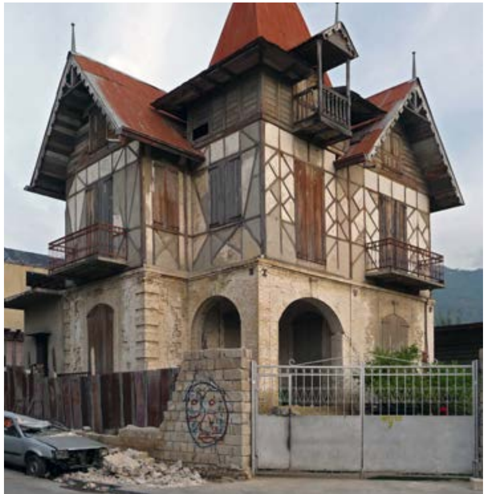
PHOTO 49 Les architectures hybrides sont très courantes. Cette maison gingerbread au 59 de la troisième Impasse Lavaud utilise les trois techniques de constructions de murs:
