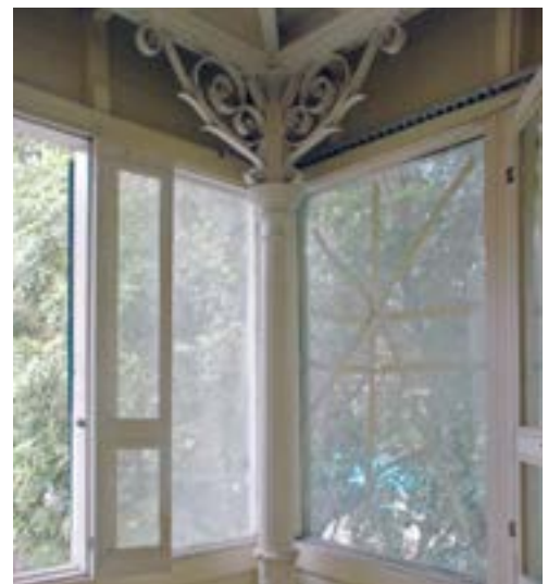
PHOTO 27 Un exemple de motifs artistiques en ferronnerie sur les balcons du deuxième étage du Manoir. Ce travail en fer forgé est masqué par des parois extérieures en bois.
