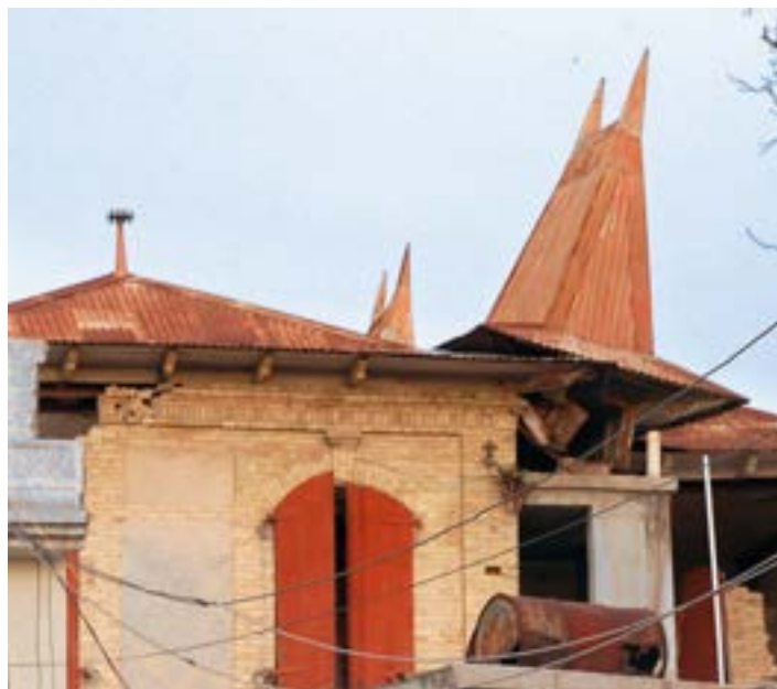
PHOTO 80 Les deux toitures en flèches de cette maison gingerbread se sont déstabilisées avec les secousses du tremblement de terre.
