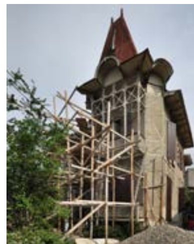
PHOTO 120 Echafaudage et étalement au 32 de l'avenue Lamartinière et étalement intérieur au 33 rue Pacot.
