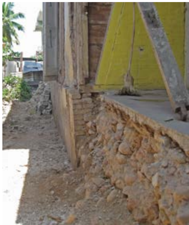
PHOTO 71 Une partie du mur de fondation de cette maison située au 2 de l'avenue N s'est effondrée, révélant que l'espace sanitaire au-dessous du rez-de-chaussée avait été comblé de remblais et que le plancher en bois avait été remplacé par une dalle sur terre-plein. Des surcharges latérales sur le mur par le hourdage ont provoqué son effondrement. Ce qui reste de la fondation de ce mur a pivoté vers l'extérieur.
