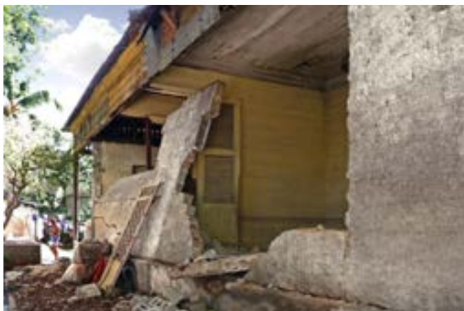
PHOTO 72 Un mur latéral de remplacement en blocs de ciment au 19 de l'avenue Lamartinière s'est effondré en partie.
