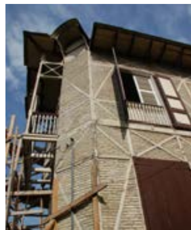
PHOTO 42 Maison située au 32 avenue Lamartinière. La charpente en bois entretoisé et briques de hourdage est un élément important de l'architecture vernaculaire.
