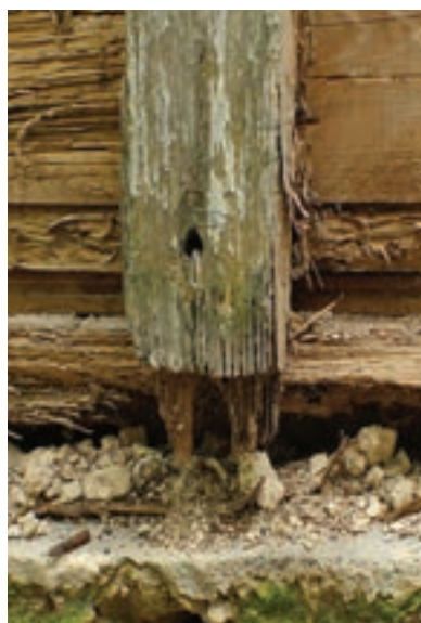
PHOTO 64 Le tenon du poteau est toujours présent; la semelle, pourrie, s'est effritée.
