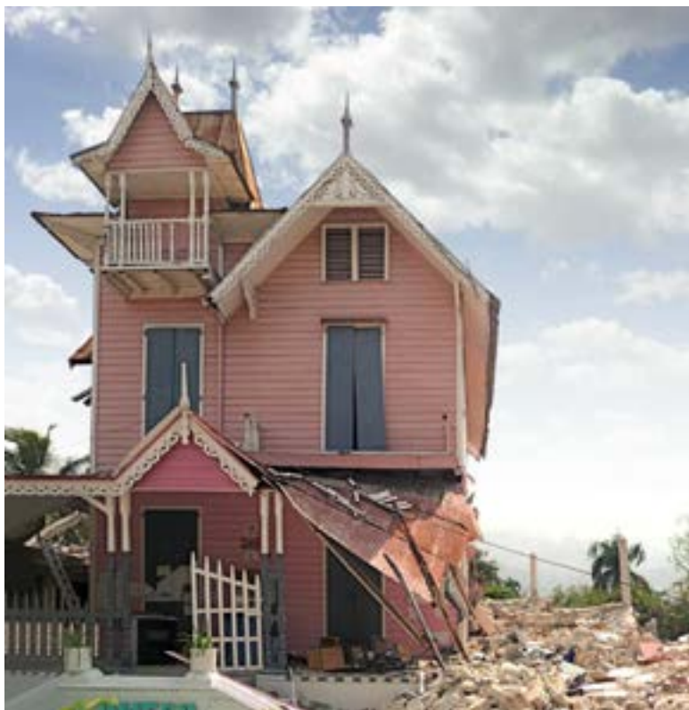
PHOTO 82 Charpente en bois d'un bâtiment gingerbread abritant l'Université de l'Eglise épiscopale au 14 de la rue Légitime, à côté du site où se trouvait un immeuble en béton qui s'est effondré.
