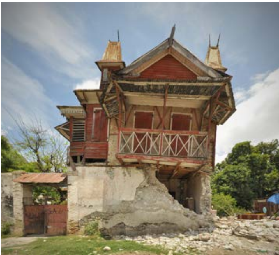
PHOTO 98 Maison à Léogâne où le mur en moellons durs s'est partiellement effondré, alors que le côté avec les ouvertures à deux battants, piliers en briques et panneaux en moellons vus à travers l'effondrement sont restés debout avec beaucoup moins de dégâts.
