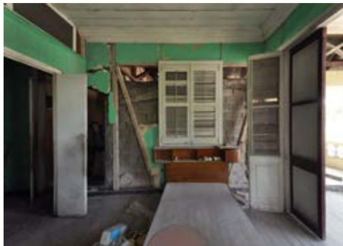
PHOTO 109 Intérieur et extérieur du 51 de l'avenue Christophe montrant l'ajout en béton armé attenant à la maison en bois et à colombage. Les deux parties se sont écarté l'une de l'autre pendant le séisme.
