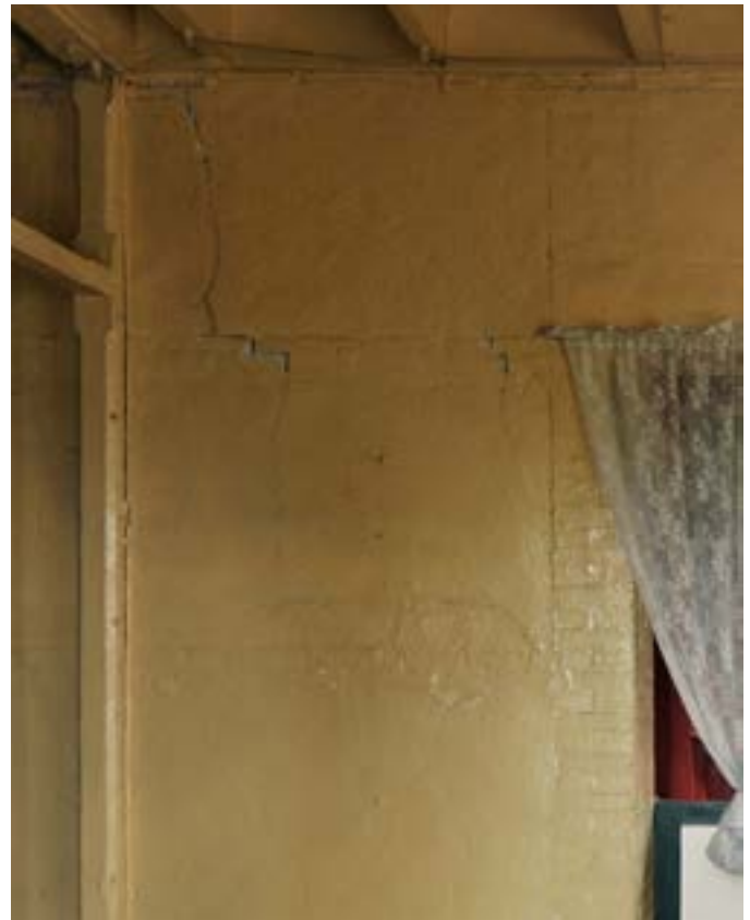
PHOTO 128 Exemples de dommages de faible intensité causés aux panneaux en moellons de murs extérieurs et intérieurs en maçonnerie.
