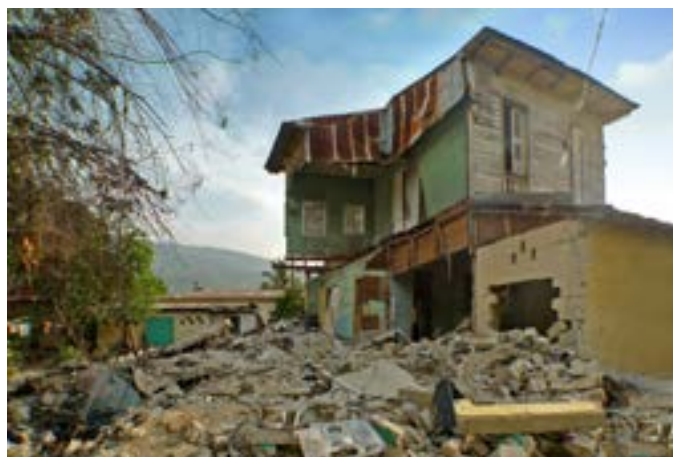
PHOTO 111 La partie en bois de ce bâtiment est restée debout, tandis que l'ajout de deux étages s'est complètement aplati. Cette maison figure aussi sur la Photo 136 droite.
