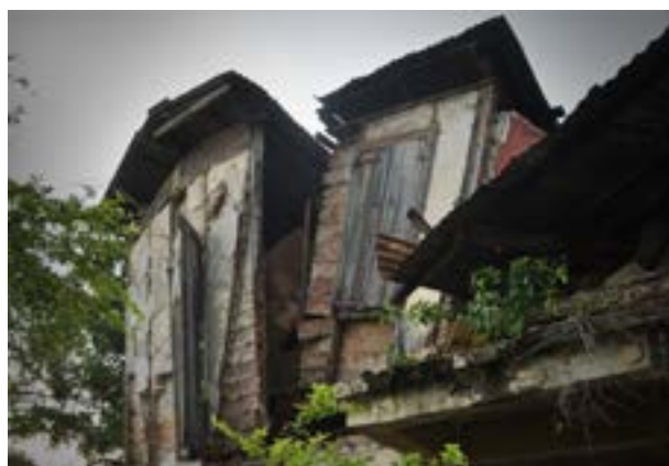
PHOTO 63 Cette maison de l'avenue Lamartinière, dans un état de pourriture très avancée et sérieusement ravagée par les termites, s'est partiellement effondrée dans le tremblement de terre.
