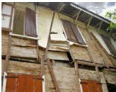
PHOTO 123 Vulnérabilité typique: les murs se détachent sur le côté parallèle à la charpente du plancher par manque de lien entre le plancher et le mur. Cet état de choses est simple à réparer dans la plupart des maisons.
