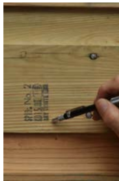
PHOTO 126 L'architecte Gilbert Mangonès explique les travaux de réparation en cour de sa maison au 24 de l'avenue Lamartinière, que l'on voit aussi sur les Photos 34, 35 et 134. Le nouveau revêtement est composé de panneaux de bois importé, traité sous pression. Le numéro de classement du bois paraît ci-dessous.
