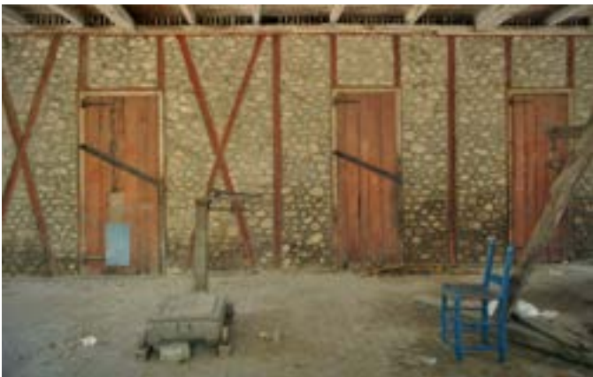
PHOTO 25 A gauche Grange à Léogâne. Exemple de colombage à moellons renforcé avec des roches ignées plus solides que celles utilisées à Port-au-Prince, et sans stuc. A droite Un pan de bois très endommagé de cette maison à colombages fait apparaître le hourdage de moellons caractéristique de Port-au-Prince. Voir aussi la Photo 86.
