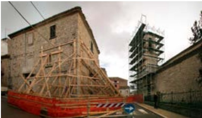
PHOTO 121 Exemples d'étaieement en Italie après le tremblement de terre de Molise, montrant les étançons en bois lourds installés en diagonale sur la photo de gauche, et les bandes en polypropylène faisant tenir l'immeuble sur la photo de droite.
