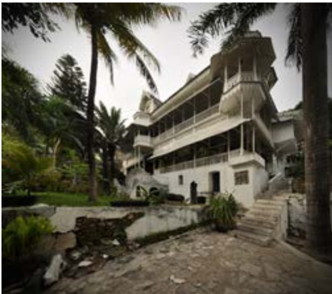
PHOTO 99 L'Hôtel Oloffson. Cette bâtisse a été construite en maçonnerie de briques, sans les panneaux en moellons. Les murs en maçonnerie sont dissimulés sur la façade par de grandes galeries en bois de style gingerbread , mais sont visibles en-dessous.
