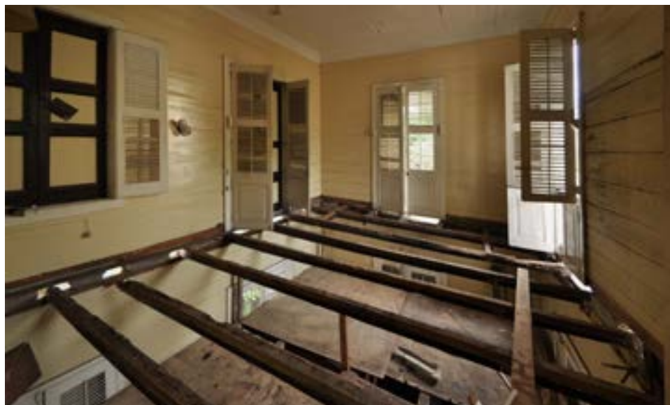
PHOTO 124 Maison au 32 de l'avenue Lamarinière en train d'être restaurée, montrant l'état de pourriture des extrémités des solives.
