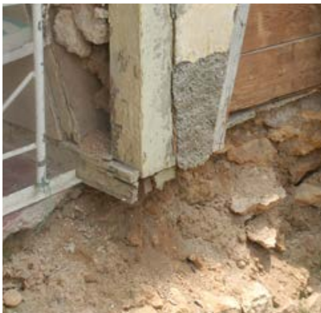
PHOTO 79 Le seuil en bois déjà ravagé par les termites s'est écrasé pendant le tremblement de terre. La structure complète s'est alors tassée sur ses fondations. En conséquence, presque toutes les portes de sortie ne peuvent ni s'ouvrir ni se fermer.
