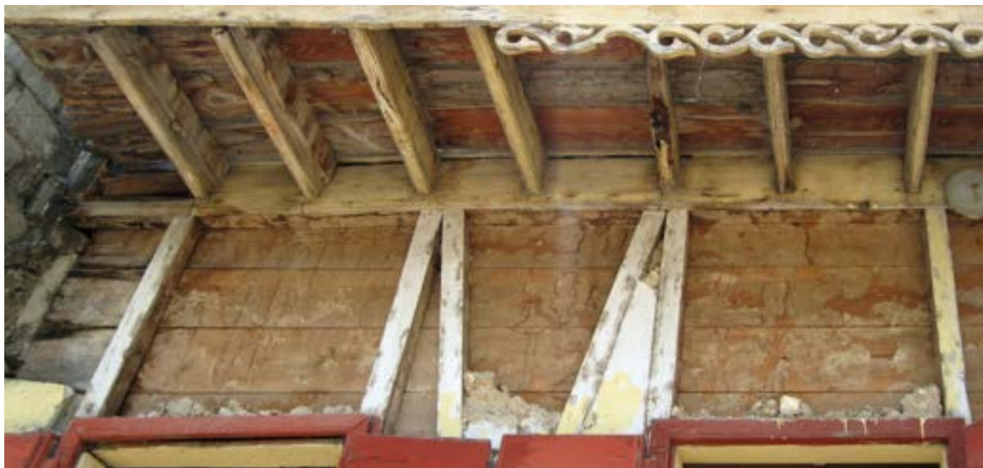
PHOTO 66 Une mauvaise construction et un mauvais appareil ont causé le délabrement de beaucoup de balcons et les ont rendus structurellement dangereux. Dans le cas des balcons en porte-à-faux soutenus par des solives, la détérioration peut se propager à la maison, mettant en danger et le balcon et l'intérieur de l'étage.
