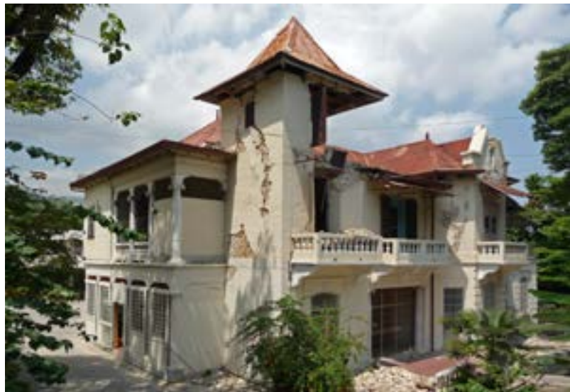
PHOTO 3 Le séminaire catholique au no. 110, rue de la Fleur-du-Chêne. On peut voir l'effondrement partiel de la tour d'angle de cette construction à palier console.
