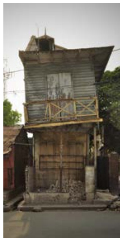
PHOTO 90 Une maison rudimentaire à panneaux de bois et colombages de la rue Geffrard près du Palais National. Cette structure semble avoir été conçue pour être agrandie et doublée en largeur, sans que ce projet n'ait jamais été réalisé. En conséquence, elle a subi le séisme avec une base de moins 3,6 mètres (12 pieds) de largeur. Déjà en très mauvais état de conservation à cette époque, elle a malgré tout résisté au séisme sans s'écrouler.
