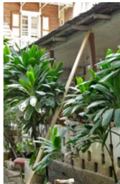
PHOTO 119 Les mesures temporaires sont importantes: cet étançon est une bonne idée, mais il est trop mince et il n'y a qu'un.
