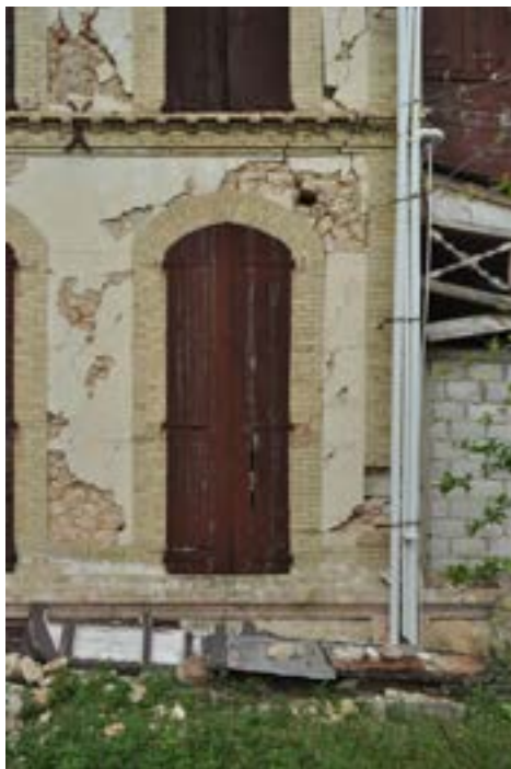
PHOTO 108 La Villa Castel Fleuri montre les effets de l'absence des chaînes en fer au niveau des angles du premier étage. Le pilier de droite a été légèrement déplacé vers la droite au premier étage. Il est possible de le réparer sans avoir à le reconstruire, mais la déviation restera visible. Une restauration de meilleure qualité et plus résistante nécessitera un étaieement et une nouvelle couche de maçonnerie dans les angles du bâtiment avec d'autres éléments de maçonnerie pour remplacer les moellons. La maçonnerie de reconstruction ne sera nécessaire que pour une partie de la voûte jusqu'à environ à son milieu.
