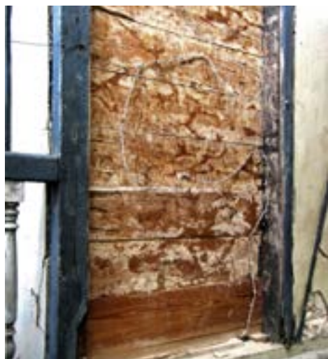
PHOTO 40 Dans cette maison à colombage, le hourdage en moellons s'est effondré pendant le tremblement de terre, révélant le renforcement en fil de fer barbelé. Il s'agit là d'un exemple de matériaux mal adaptés à la construction utilisés à cause de leur disponibilité apparente. Le fil de fer barbelé était galvanisé et est encore en bon état.
