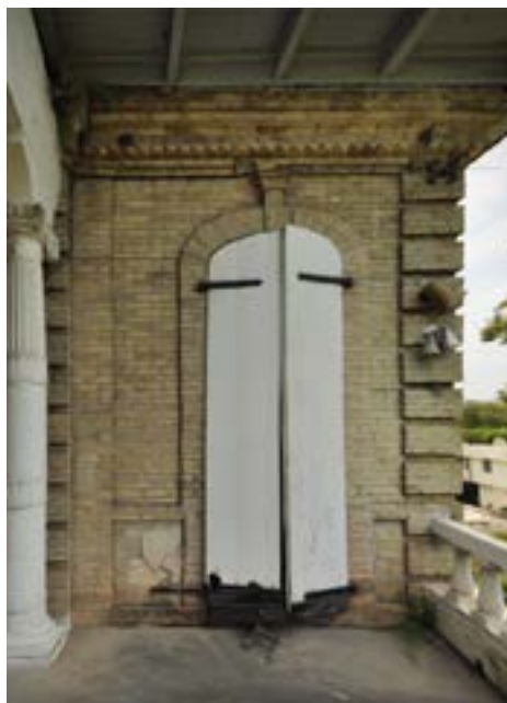
PHOTO 108 La Villa Castel Fleuri montre les effets de l'absence des chaînes en fer au niveau des angles du premier étage. Le pilier de droite a été légèrement déplacé vers la droite au premier étage. Il est possible de le réparer sans avoir à le reconstruire, mais la déviation restera visible. Une restauration de meilleure qualité et plus résistante nécessitera un étaieement et une nouvelle couche de maçonnerie dans les angles du bâtiment avec d'autres éléments de maçonnerie pour remplacer les moellons. La maçonnerie de reconstruction ne sera nécessaire que pour une partie de la voûte jusqu'à environ à son milieu.
