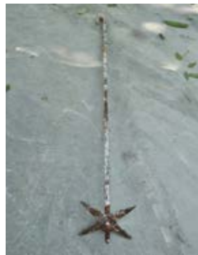
PHOTO 101 Chaînes en fer typiques dans de nombreux murs en maçonnerie des maisons gingerbread de Port-au-Prince. En haut on peut apercevoir la première partie de la chaîne avec la plaque de métal en forme d'étoile. À gauche , on peut voir les plaques de métal là où elles retiennent encore le mur en place au niveau du plancher de l'étage, stoppant ainsi la séparation additionnelle des murs dans les angles. Si ces anneaux de renforcement n'avaient pas été installés au niveau du plancher de cet étage, les murs de l'étage du dessous se seraient très probablement effondrés aussi.
