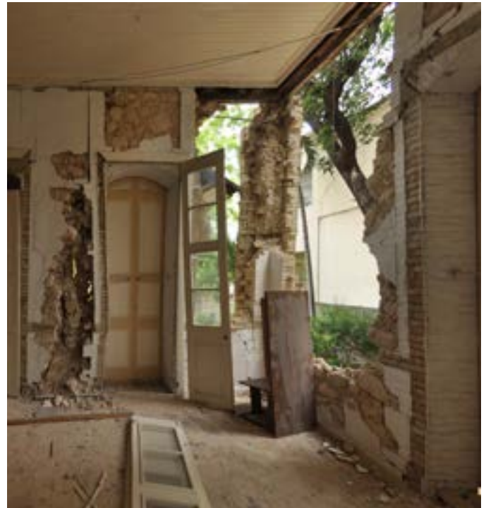
PHOTO 95 En haut, à gauche La maison Dufort montrant l'effondrement des panneaux en moellons, laissant debout les piliers retenant l'étage supérieur presque intact. L'énorme amas devant la maison montre le volume de la maçonnerie de moellons qui a été enlevé de la maison après son effondrement. En haut, à droite L'intérieur de la maison Dufort, vu aussi sur la Photo 77, montre comment l'écroulement des panneaux en moellons a laissé la maison sur les piliers en briques qui sont restés debout ressemblant à des colonnes libres. À gauche cette maison était également renforcée par des chaînes en acier et en fer forgé faites de tiges d'ancrage accrochées ensemble tout le long des murs extérieurs et des principaux murs intérieurs. Dans ce cas, au lieu d'utiliser des plaques extérieures pour les retenir, leurs ancrages au mur étaient enfouis sous la paroi extérieure de la maçonnerie. Les tiges d'ancrage sont également visibles là où elles s'entrecroisent dans le pilier d'angle qui est toujours debout et que l'on peut voir plus clairement sur la Photo 93.
