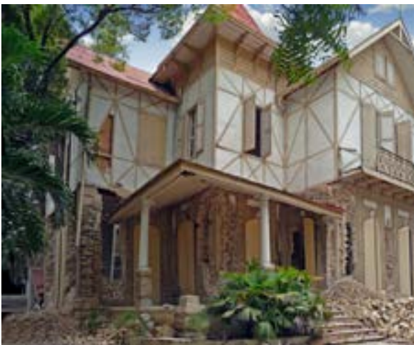
PHOTO 77 La maison Dufort, une construction hybride, a subi des dégâts importants dans la maçonnerie des murs du rez-de-chaussée, y compris ses panneaux en pierres calcaires et piliers en briques avec, cependant, beaucoup moins de dommages au colombage et aux murs en bois du second étage. Nonobstant les charges sismiques croissantes sur les murs du premier étage, la différence dans la résistance des systèmes est une indication d'une tendance observée dans tous les bâtiments inspectés.
