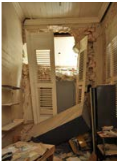
PHOTO 69 Un trou dans le mur en maçonnerie du Castel Fleuri causé par une voute en béton construite du côté extérieur et adjacente à ce mur.
