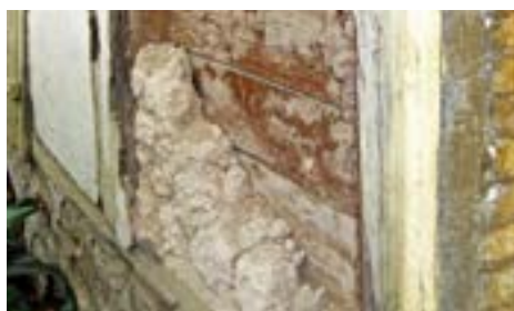
PHOTO 87 Gros plan du moellonnage raté de ce colombage. Ce hourdage, s'il était en argile, se serait effrité sans compromettre l'intégrité de la charpente en bois entretoisés.
