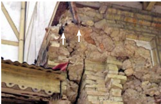
PHOTO 103 Des tirants encastés traversent les angles, ancrés par des barres de fer. A noter également le hourdage de moellons entre les faces internes et externes de la maçonnerie en briques.
