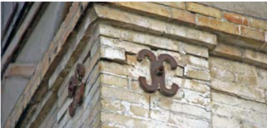
PHOTO 26 Vue des plaques de fond décoratives dans un angle de cette construction en briques dénotant la présence d'entretoises horizontales dans les encoignures le long de chaque mur.
