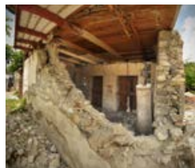
PHOTO 98 Maison à Léogâne où le mur en moellons durs s'est partiellement effondré, alors que le côté avec les ouvertures à deux battants, piliers en briques et panneaux en moellons vus à travers l'effondrement sont restés debout avec beaucoup moins de dégâts.
