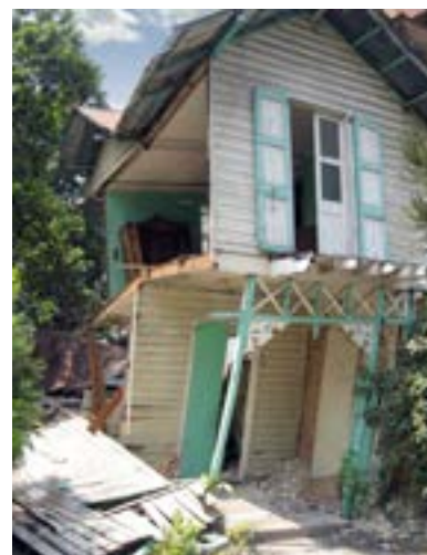
PHOTO 85 Malgré des dégâts importants, ce bâtiment à charpente de bois ne s'est pas totalement effondré. A noter que le mur latéral qui s'est écroulé est parallèle aux solives, n'ayant de ce fait aucune attache consistante avec le sol.
