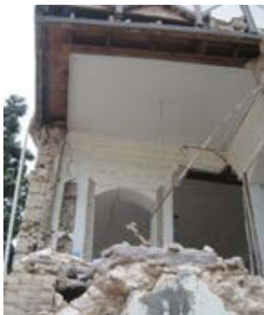
PHOTO 102 Dans ce cas particulier, les attaches en métal n'ont pas réussi à empêcher l'écroulement des ces murs en maçonnerie, mais ont peut-être sauvé de l'effondrement le reste de l'immeuble.
