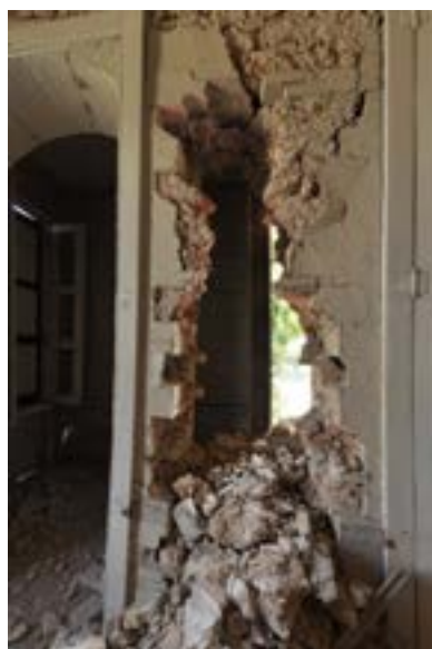
PHOTO 130 En bas, à gauche Un panneau en moellons au premier étage de la Villa Castel Fleuri qui s'est effondré montrant le déplacement de la base du pilier en briques vers la porte, résultat des forces d'expansion du panneau. En bas, à droite Le Manoir dans l'avenue John Brown montrant le degré des perturbations des murs en maçonnerie, causés par la dégradation rapide des panneaux en moellons pendant le séisme.
