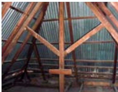
PHOTO 54 Un toit en feuilles de tôles ondulées au-dessus des pannes sablières et de la charpente en bois entretoisé.
