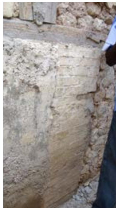
PHOTO 51 Le pilier de soutènement original en maçonnerie de briques est visible avec son hourdage composé de stuc et de moellons. L'humidité provenant du sol a causé une détérioration considérable à la maçonnerie de moellons exposée. Ceci est le résultat de la migration de sels solubles à la surface où ils se dilatent en séchant, causant l'effritement de la couche de maçonnerie.
