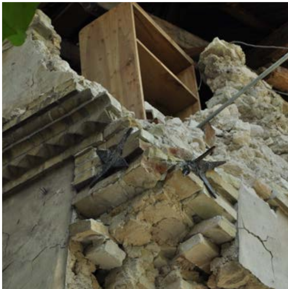
PHOTO 101 Chaînes en fer typiques dans de nombreux murs en maçonnerie des maisons gingerbread de Port-au-Prince. En haut on peut apercevoir la première partie de la chaîne avec la plaque de métal en forme d'étoile. À gauche , on peut voir les plaques de métal là où elles retiennent encore le mur en place au niveau du plancher de l'étage, stoppant ainsi la séparation additionnelle des murs dans les angles. Si ces anneaux de renforcement n'avaient pas été installés au niveau du plancher de cet étage, les murs de l'étage du dessous se seraient très probablement effondrés aussi.
