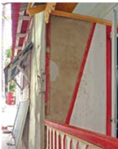
PHOTO 135 Des réparations bien intentionnées mais inadéquates avec mortier en ciment dans un appareil en briques (en haut et à droite) et un hourdage de ciment pour un colombage (en bas). Torchis de chaux et plâtre de chaux devraient être utilisés.
