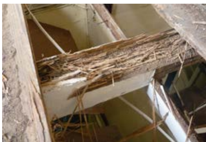
PHOTO 68 Dégâts causés par les termites aux solives du premier étage.
