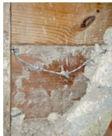
PHOTO 125 Du fil de fer barbelé est souvent observé dans les cavités des murs pour retenir le hourdage de moellons. Il s'agit là d'une bonne pratique qu'il est important de poursuivre.
