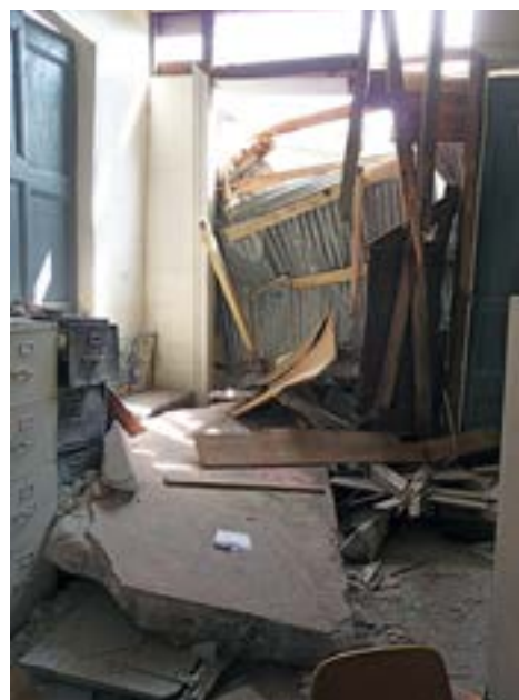
PHOTO 116 Les plus importants dégâts dont a souffert cette gingerbread proviennent d'une dalle de béton catapultée à travers la porte arrière pendant l'effondrement du bâtiment en béton située derrière elle. La toiture de la galerie a également été endommagée par l'effondrement d'un immeuble en béton attenante (voir aussi la Photo 82).
