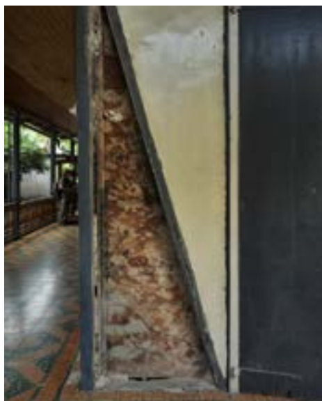
PHOTO 41 Maison au 15 rue M montrant un hourdage de moellons. A gauche, une paroi s'est écroulée pendant le tremblement de terre, révélant qu'elle avait été renforcée avec du fil de fer barbelé intégré en zigzag dans les entrevous.
