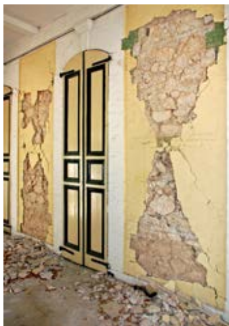
PHOTO 115 Les fissures caractéristiques en X sur les murs à hourdage de maçonnerie des charpentes en béton peuvent être également remarquées au Manoir. Elles ont été causées par la dalle de béton armé du premier étage (au-dessus du mur endommagé, sur cette photo).
