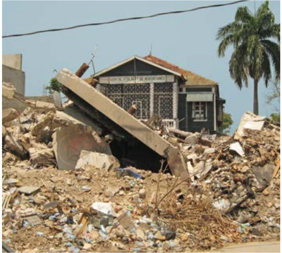
PHOTO 118 Spectacle typique, une gingerbread debout intacte derrière ce qui reste d'un bâtiment moderne en béton qui s'est effondré.
