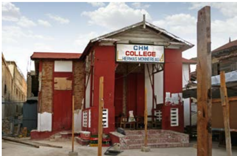
FIGURE 112 Petite maison à colombage accueillant une école au 16 de l'avenue Lamartinière et un immeuble de deux étages derrière elle. De grosses portions de cet ajout se sont effondrées complètement, mais le bâtiment original est intact et toujours en service.
