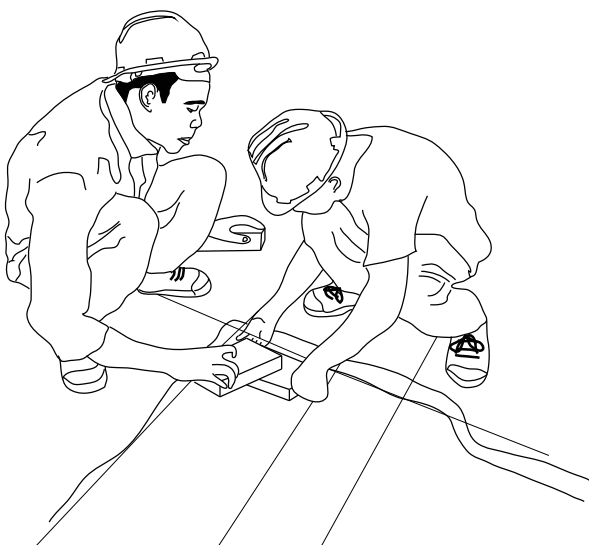
Travail avec les briques à sec sur la poutre de béton pour bien définir l'appareillage
