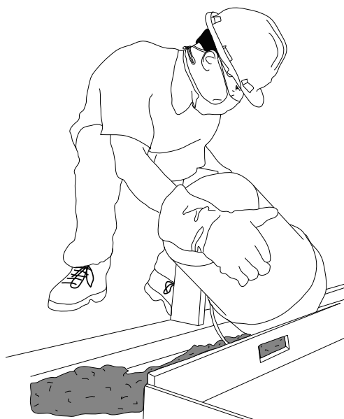
Le béton a été coulé à la main dans les tranchées.
