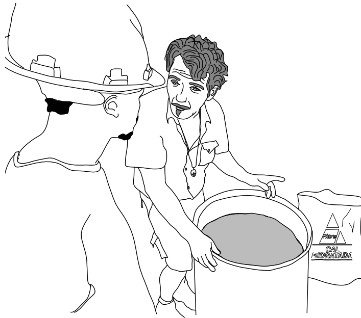
Préparation de l'eau de chaux
