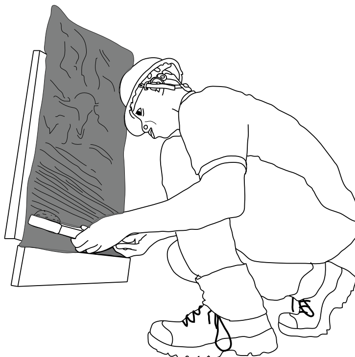
Polissage de l'enduit
