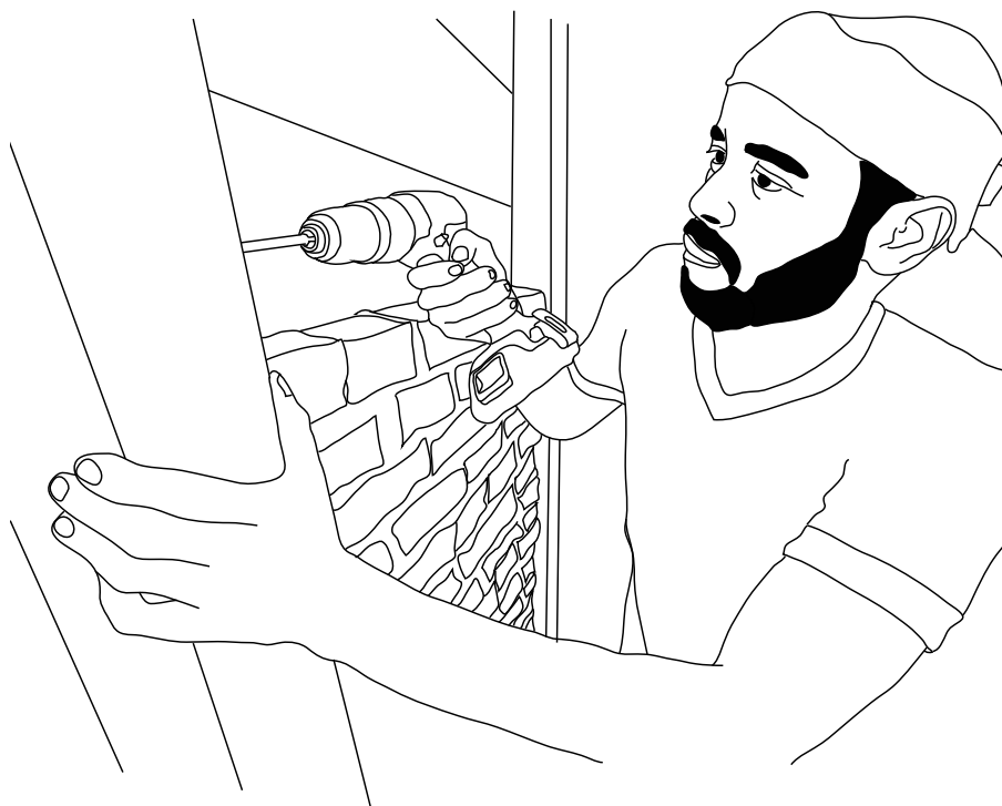
L'insertion des petits tirants dans le remplissage
