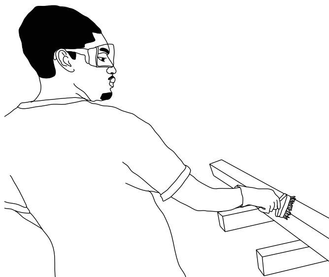
Application des produits insecticides sur un morceau de bois avant de l'utiliser pour les réparations
