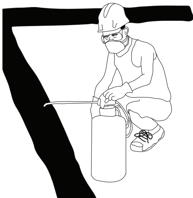
Application des produits insecticides dans les tranchées avant de couler du béton pour la fondation
