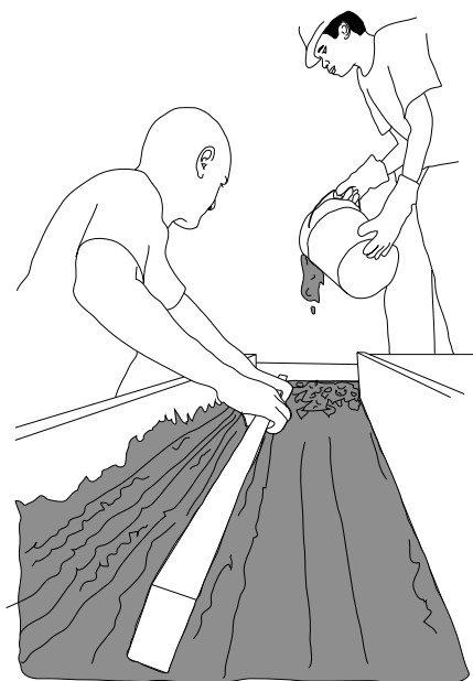
Lissage du béton
