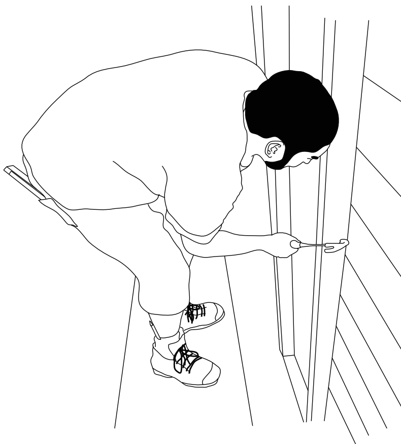
Chaque morceau de charpente a été examiné avec un marteau
