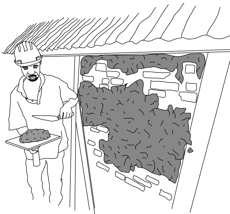
Application d'enduit sur les panneaux de remplissage
