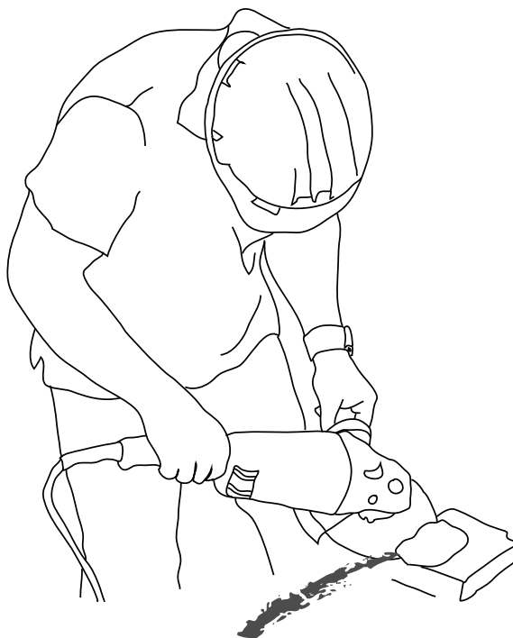
Découpage des briques à la main
