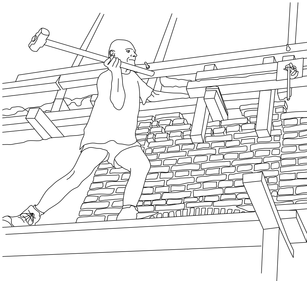
L'étage a été débloquent avec quelques coups de masse sur les points d'ancrage de la façade ouest.
